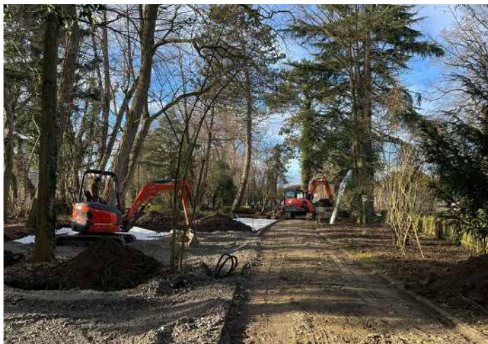
Einfahrt und Parkplätze in Bau. Alle Fotos: © Norbert Jud
