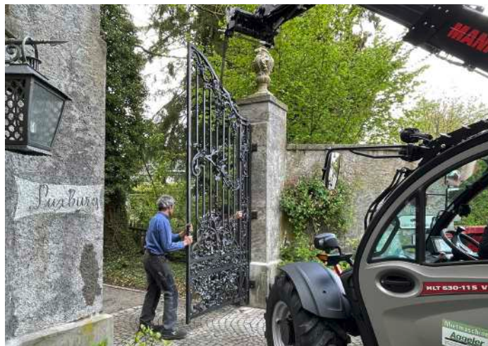
Renoviertes Schmiedeeisentor wird montiert
